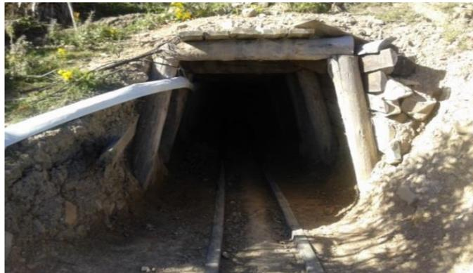
**Artículo 78.** *Sostenimiento adecuado.* El responsable técnico de la labor subterránea y el supervisor de turno deben asegurar la existencia de sostenimiento adecuado y en la densidad requerida, en los frentes de explotación o recuperación, de acuerdo con el avance de los trabajos y las presiones existentes en la zona
