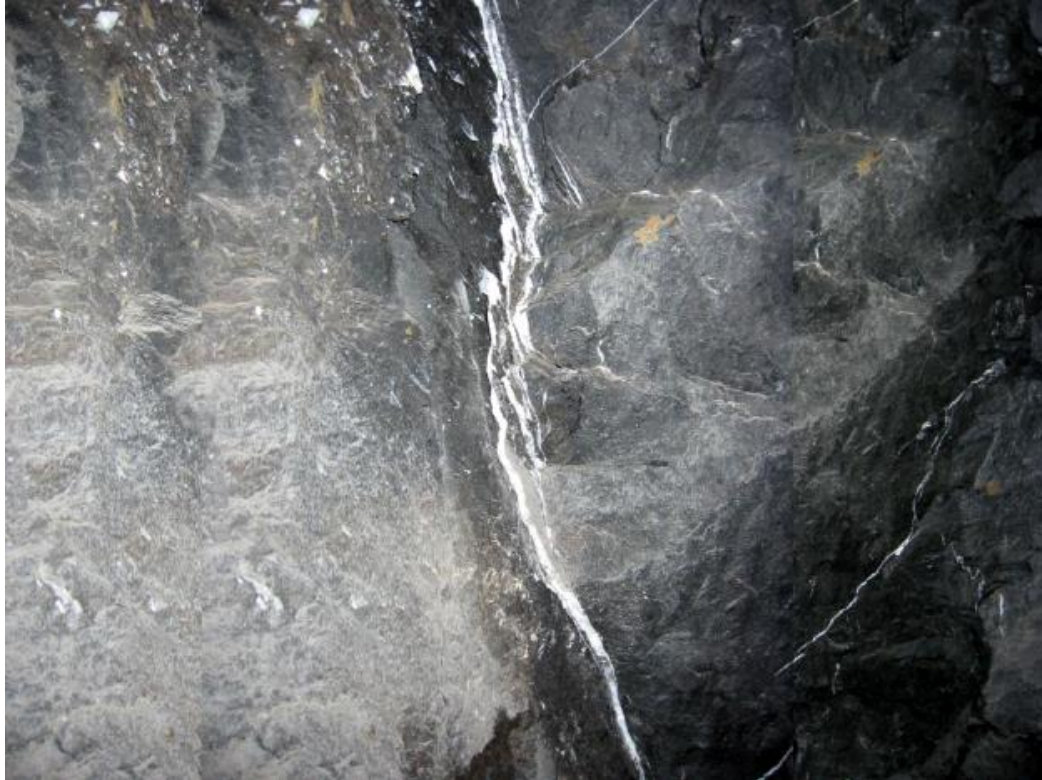
Figura 44. Relleno de las discontinuidades en un frente de macizo rocoso
