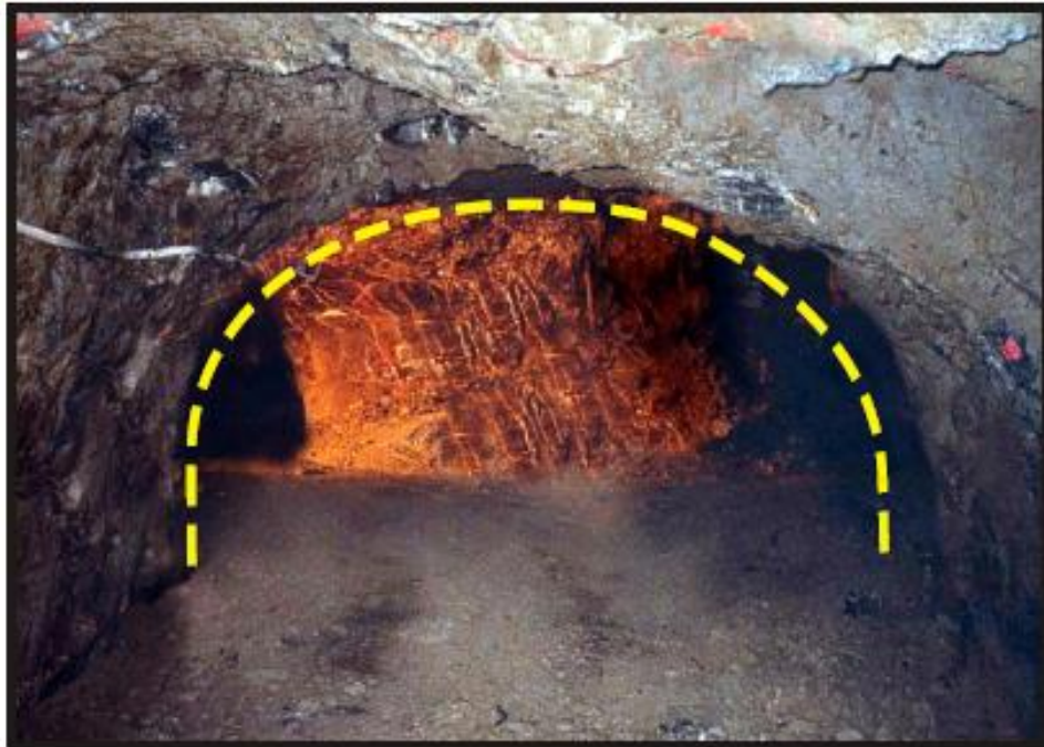
Figura 65. Forma favorable de una excavación
