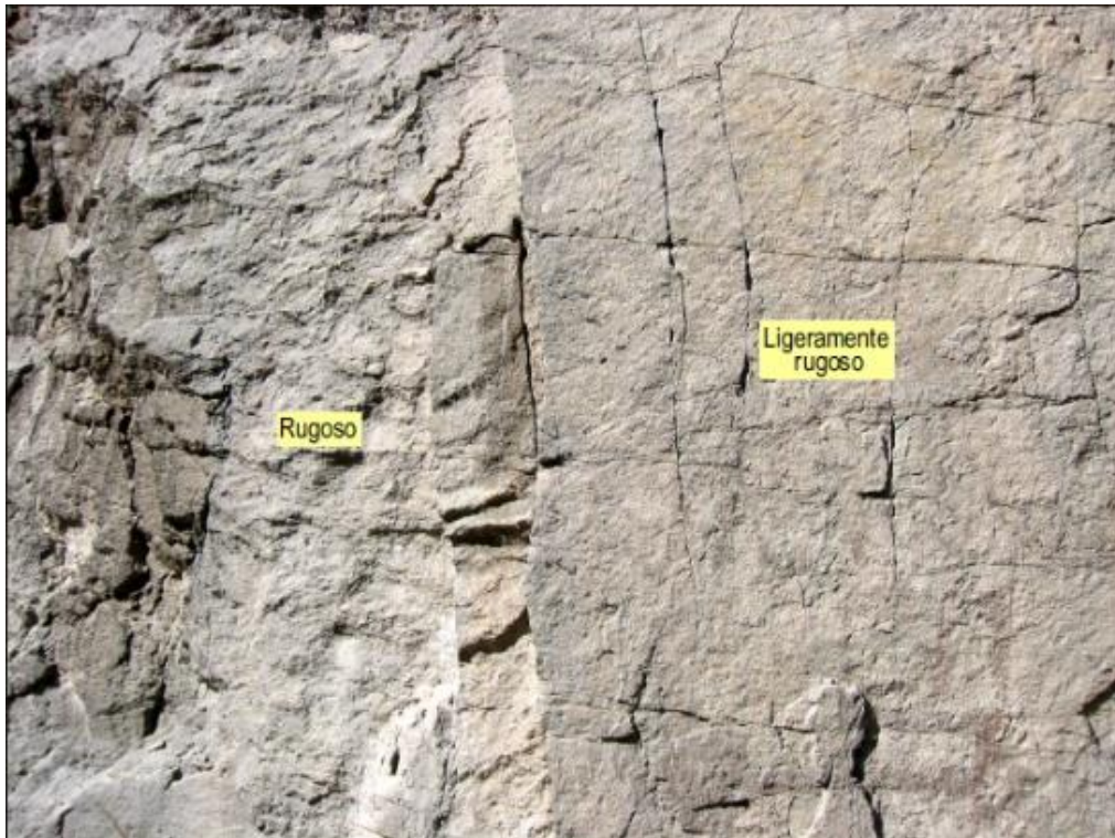
Figura 42. Rugosidad de las discontinuidades en un frente de macizo rocoso
