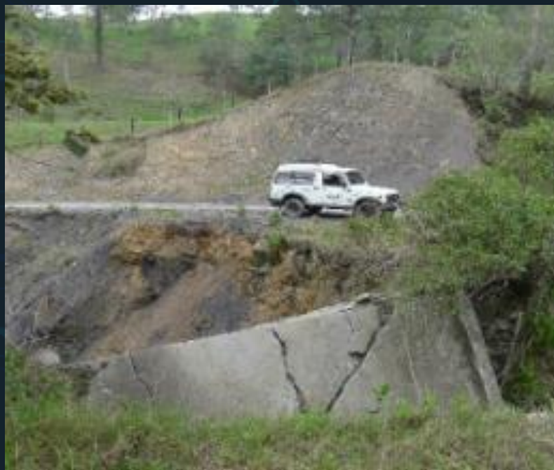
Foto 67. Procesos de socavación de un afluente del río Batán, vereda San Miguel
