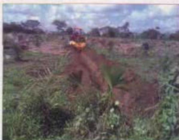
Figura 62. Canales interlineales construidos con zanjadora rotativa (foto Jesús López).
