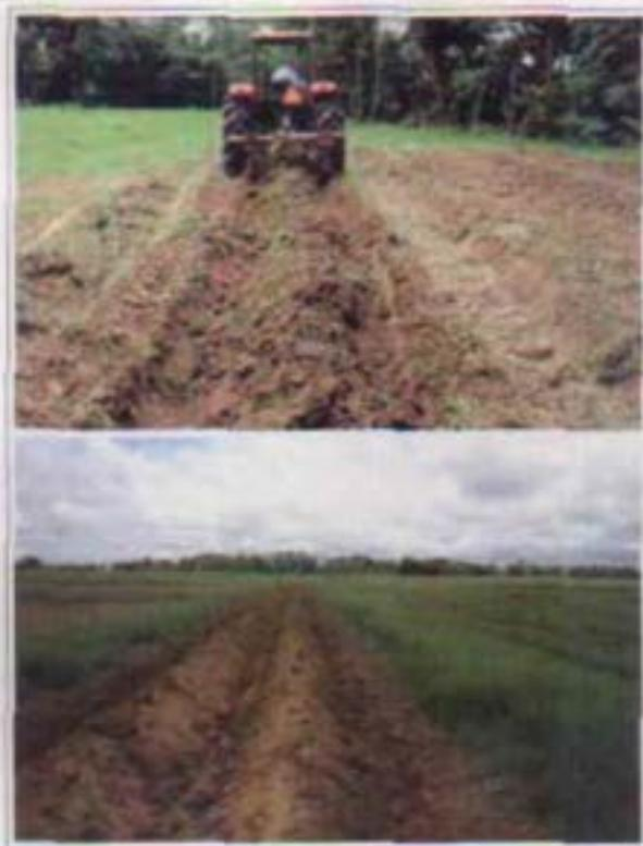
Figura 66. Canal de riego construido con caballoneador (fotos del autor).
