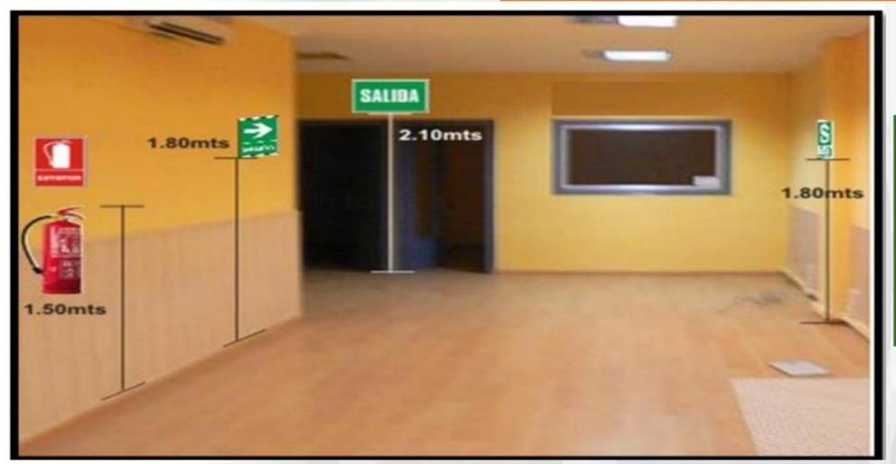
Las señales de salida y salida de emergencia o escape se colocarán en la parte superior del marco de la puerta de evacuación.
