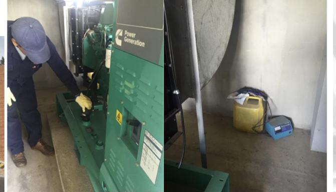
Foto 7. Planta eléctrica, galón de ACPM y punto de llenado.
