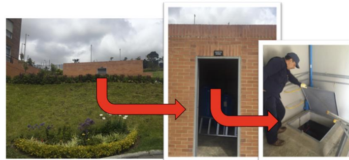
Foto 6. Ubicación del tanque de agua del conjunto.
