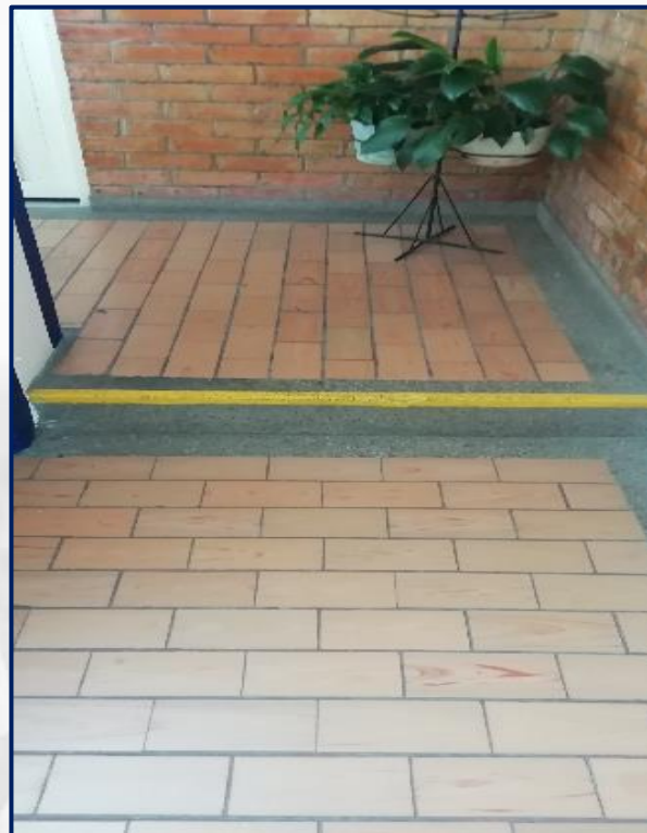
2) Los desniveles estén demarcados (Línea de aprox. 5 – 10 cm de ancho. Color amarillo).
