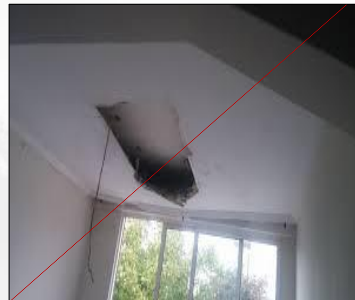
11) Techos sin desprendimientos
