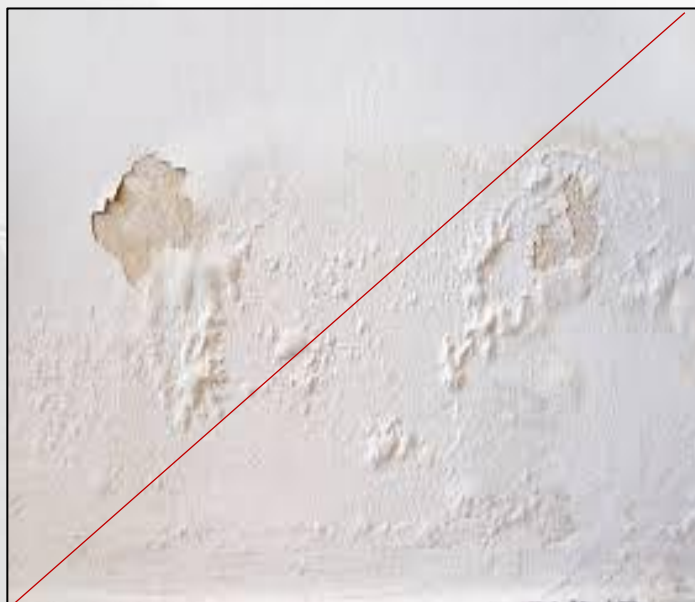
10) Paredes sin grietas ni humedad
