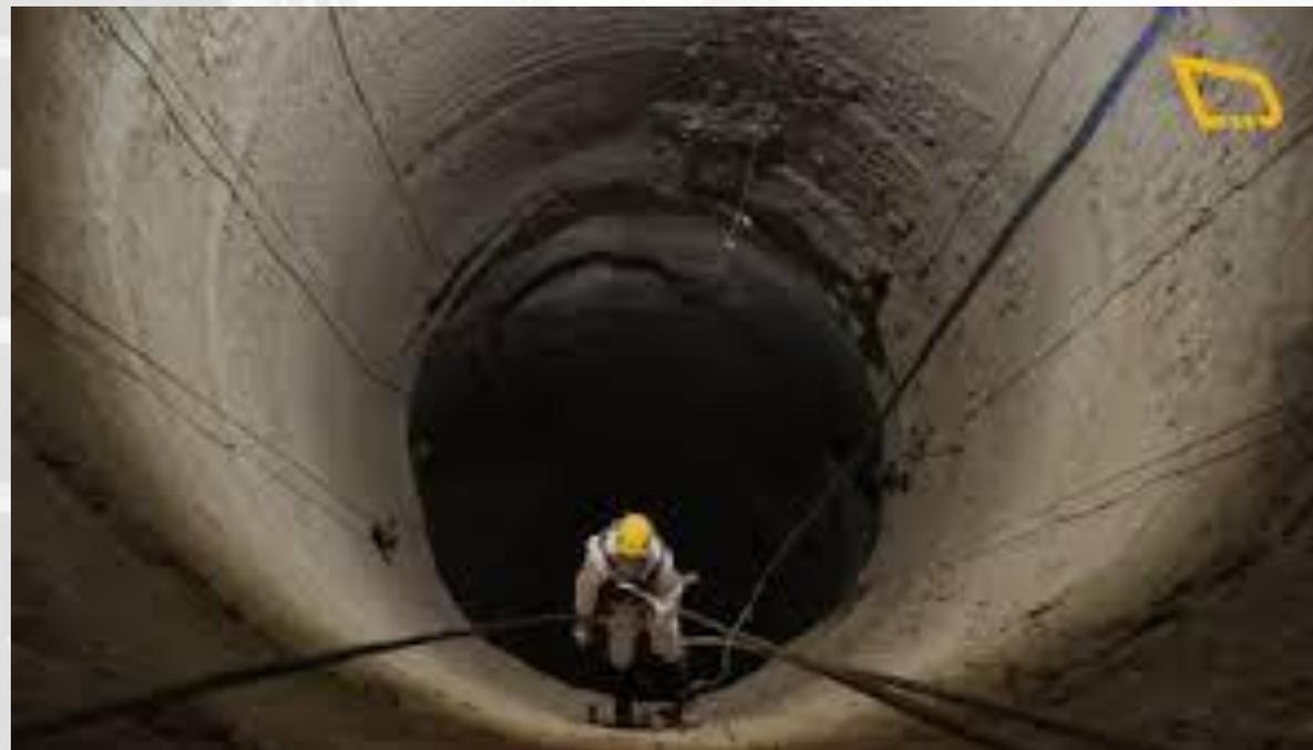
Están debidamente ancladas a una determinada estructura, fabricadas en cable de acero, cuerda, o rieles u otros materiales. **Deben ser diseñadas e instaladas por una persona calificada.**
