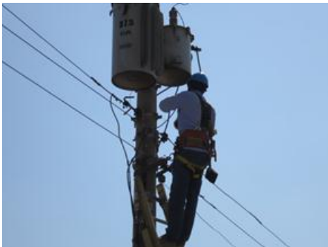
Gráfica 41. Posiciones de trabajo en instalación de redes
