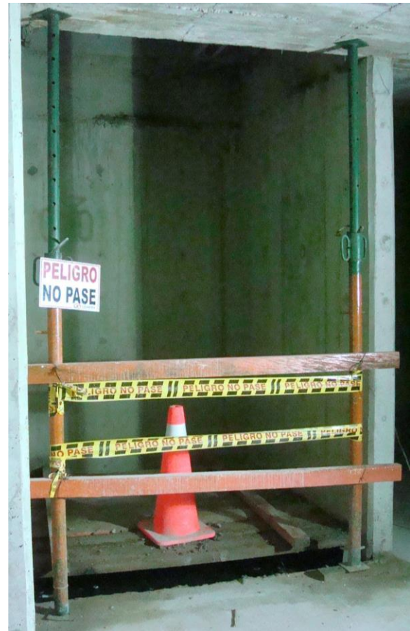
Gráfica 20. Cerramiento con materiales reprocesados.
