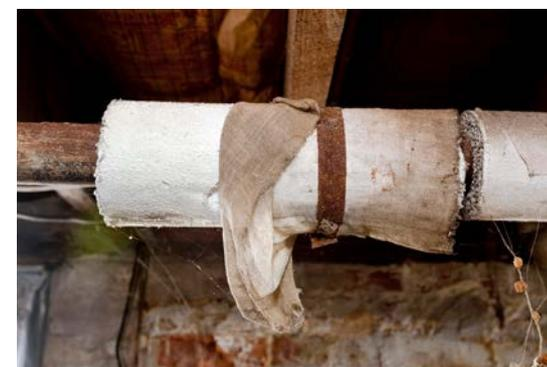
Material con asbesto amosita
